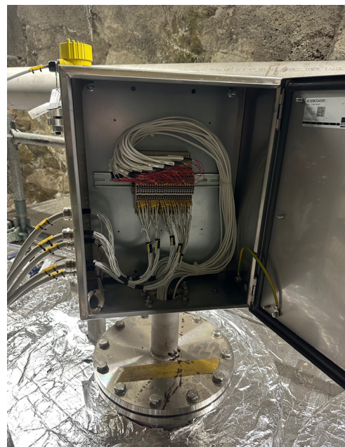
Mångpunktsgivare installerad i processen
